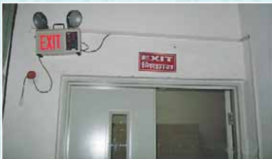
Emergency Light/ Exit Opening Outwards आणीबाणी दिवे बाहेर जाणाच्या बाहेरच्या बाजूला उघडणारा दरवाजा
